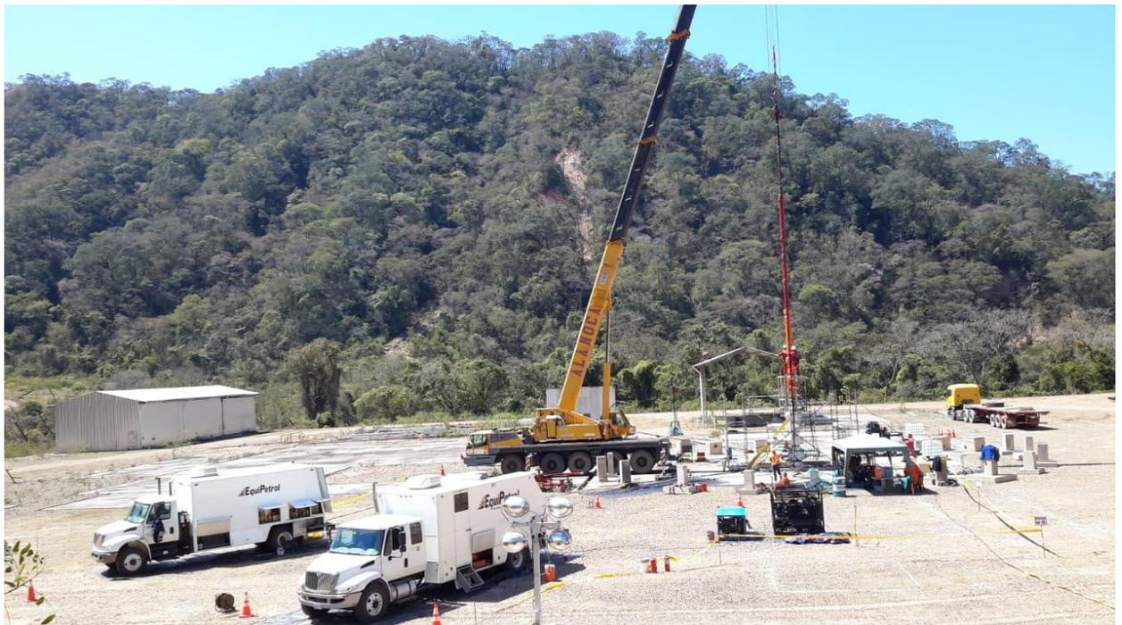
**Foto: Equipo de Control de Presión de 7" y unidad de SLK y WL**
